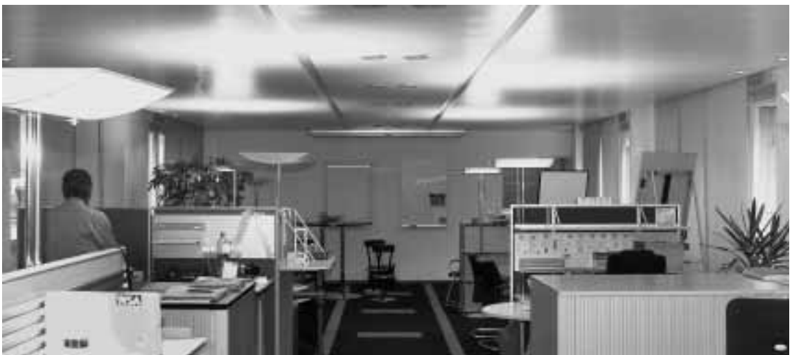
Bilder 113-115 Gute Leuchten für Bildschirmarbeitsplätze: Deckenleuchte, direkt-indirekt strahlend.
