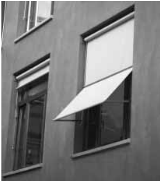
Bild 105 Für Bildschirmarbeitsplätze ungeeignete Stoffstoren (zu dünner Stoff erlaubt keine wirksame Abdunklung bei Sonneneinstrahlung, Lichteinfall seitlich durch die Spalten).
