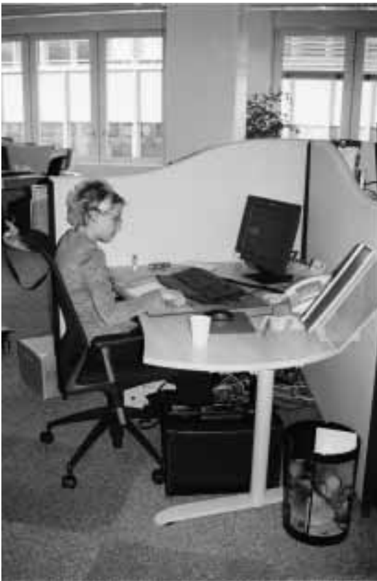
Bild 123 Raumakustische Massnahme in einem Call-Center: absorbierende Stellwände zwischen den einzelnen Arbeitsbereichen.
